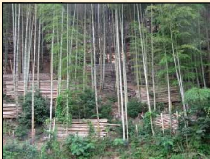
↑ スギ・ヒノキ林の間伐・筋工 間伐の実施と伐採木を活用した筋工の施工により、下層植生を繁茂させることで、表土流出を抑止（三重県亀山市）
