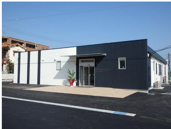
生物多样性センター 本館
