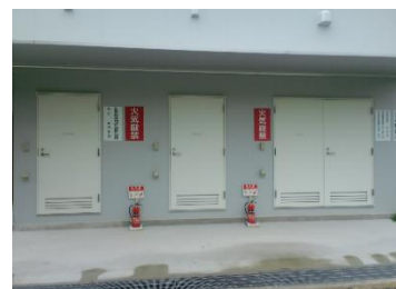
危険物屋内貯蔵所
