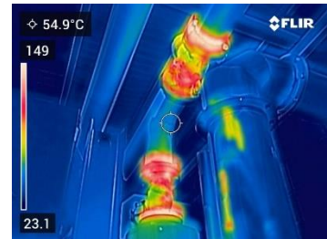
省エネ診断時における断熱状況の確認
