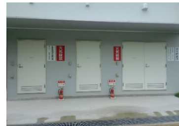
危険物屋内貯蔵所
