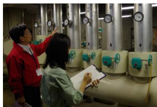
設備の運転管理状況の診断
