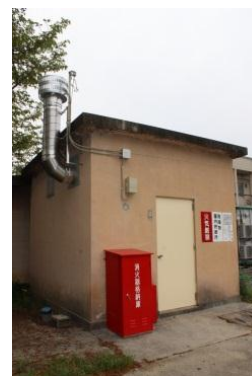
危険物特定屋内貯蔵所
