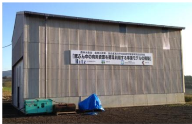
写真1 炭化現地実証施設 (宮崎県小林市)
