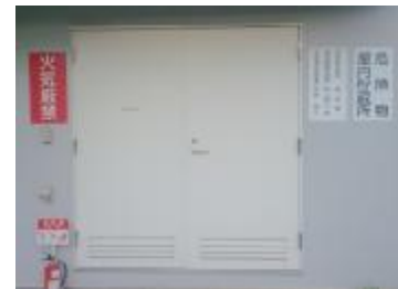
危険物屋内貯蔵所
