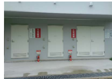
危険物屋内貯蔵所
