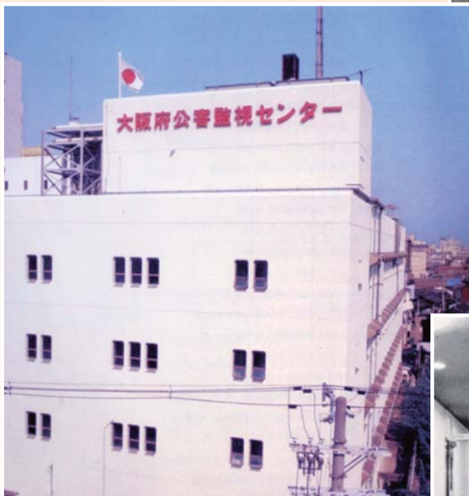
建物外観（1970[昭和45]年頃）
