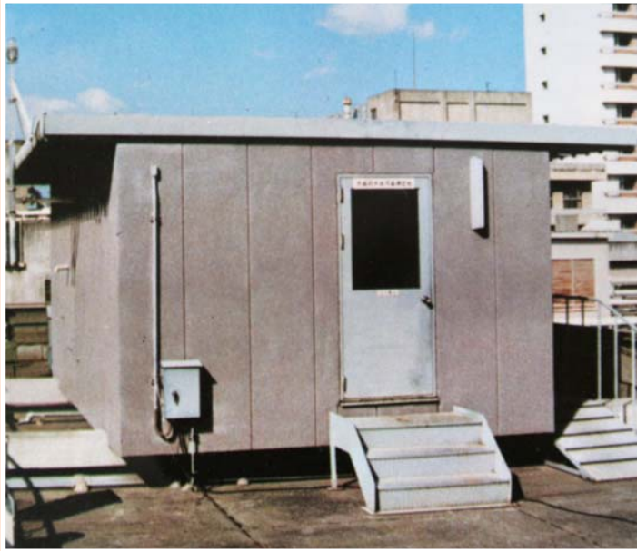
屋上に設置されていた 大気汚染常時監視測定局 (1981[昭和56]年頃)
