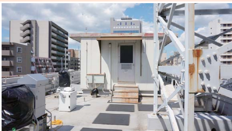
屋上の大気汚染常時監視局
