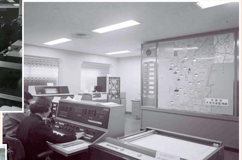
各測定局のデータを収集する中央局 (1970[昭和45]年頃) 光化学スモッグ予報などを発令
