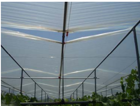
写真3 水平型開閉装置の設置状況
