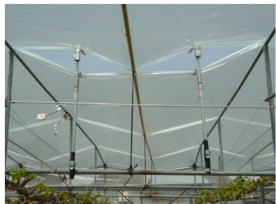
写真 開発した垂直型開閉装置の設置状況
