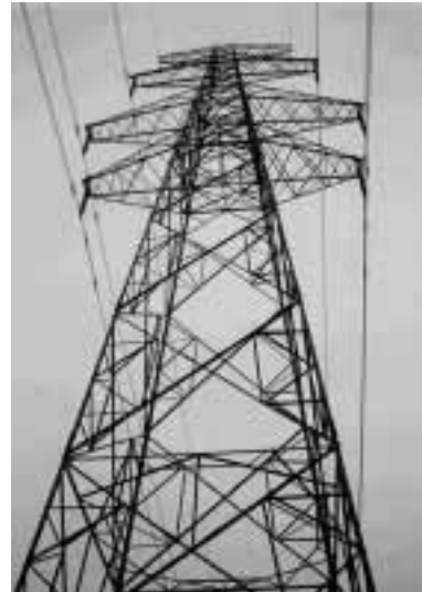
図 15. 重慶の電力鉄塔
