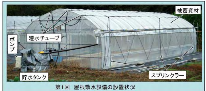
第1図 屋根散水設備の設置状況
