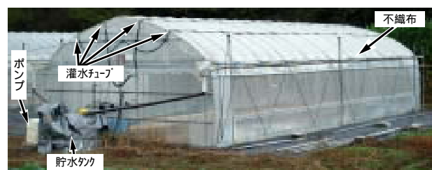
第1図 屋根散水設備の設置状況
